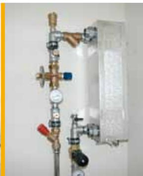
Die Übergabestation mit Wärmetauscher in den Häusern - mehr wird nicht benötigt.
